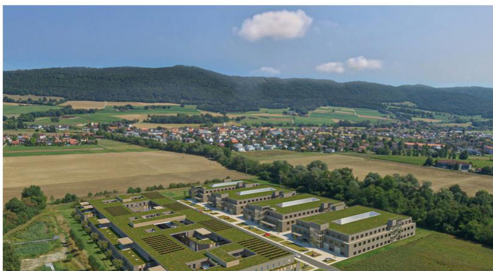
Plusieurs halles seront construites à Innodel. (Image : HBD & SAG).
